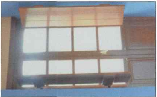
Ξύλινο κούφωμα με εσωτερικά σκάδια.
